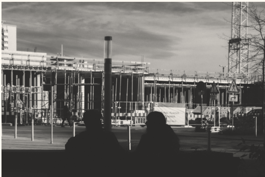
Baustellenromantik in der neuen Johannistorstadt, Foto: Marcel I.
